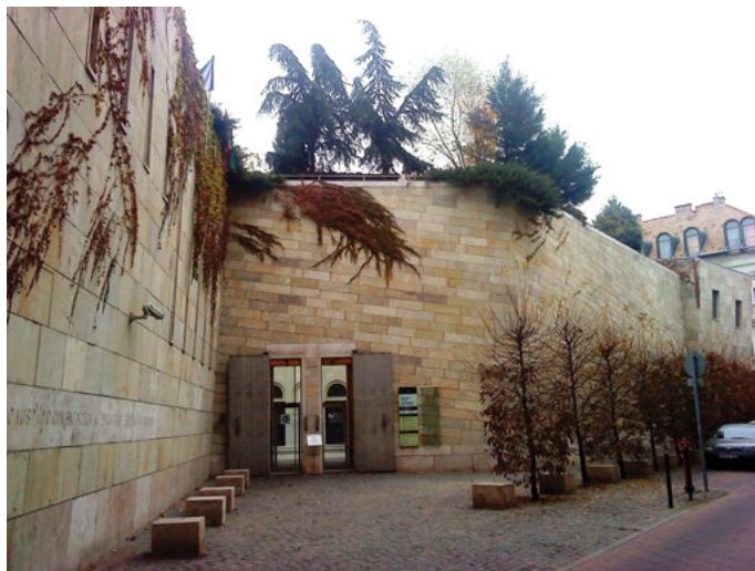
Abb. 22: Hohe Mauern umgeben das Holocaust-Gedenkzentrum in Budapest.
