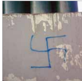
София, Метростанция „Сливница“
